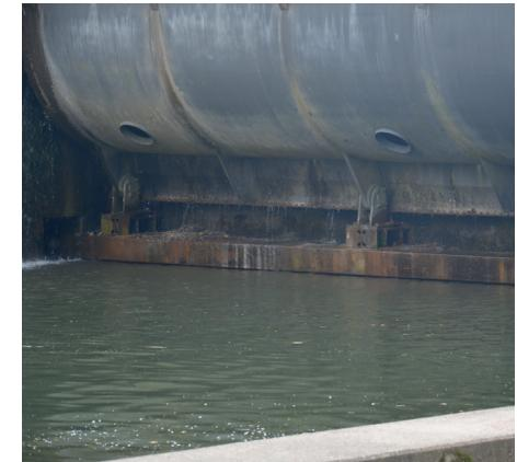
Bei der Wehrklappe am Kraftwerk Lechen ist es zu einem Schaden im Bereich der Lagerung und am linken Klappenzylinder gekommen. Es soll durch eine Befundaufnahme des Schaden und einer Bemessungskontrolle die Schadensursache ermittelt werden. Außerdem soll im Anschluss ein Vorschlag für die Neugestaltung der Lagerkonsole erarbeitet werden.
